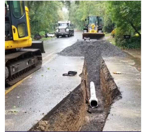
Zanja de la tubería en SW Garden View Avenue
